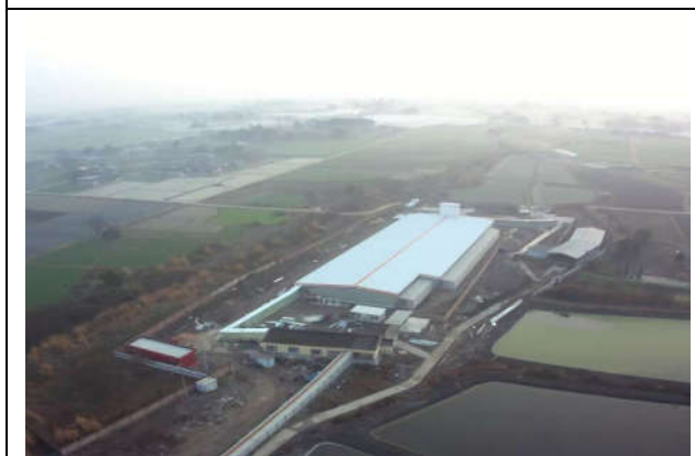
建设场地现状
