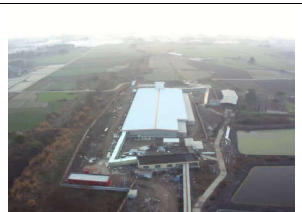
建设场地现状
