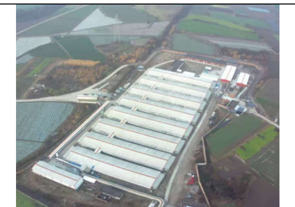
建设场地现状
