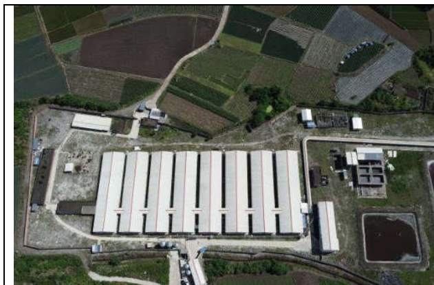
建设场地（施工前原始）
