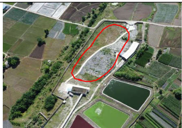
建设场地（施工前原始）
